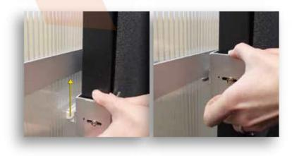
3. PLACE BRACKET AROUND THE EDGE OF THE CUBICLE WALL. SLIDE BRACKET UP TO REST UNDERNEATH DOOR GUIDE RAIL.
